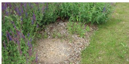
Puits d'infiltration (Source : Fiches CG 92)
